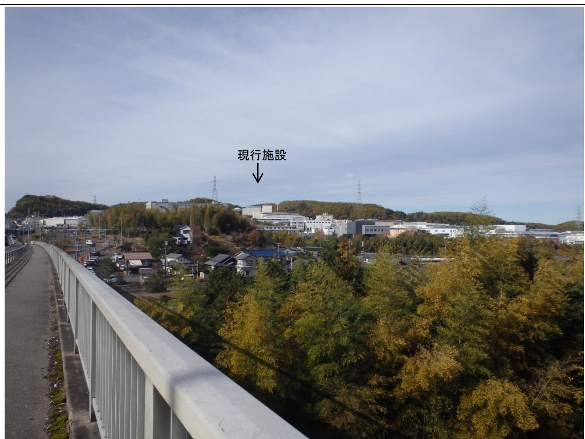
㊸松尾川大橋(国道 170 号)の現況(冬季)
