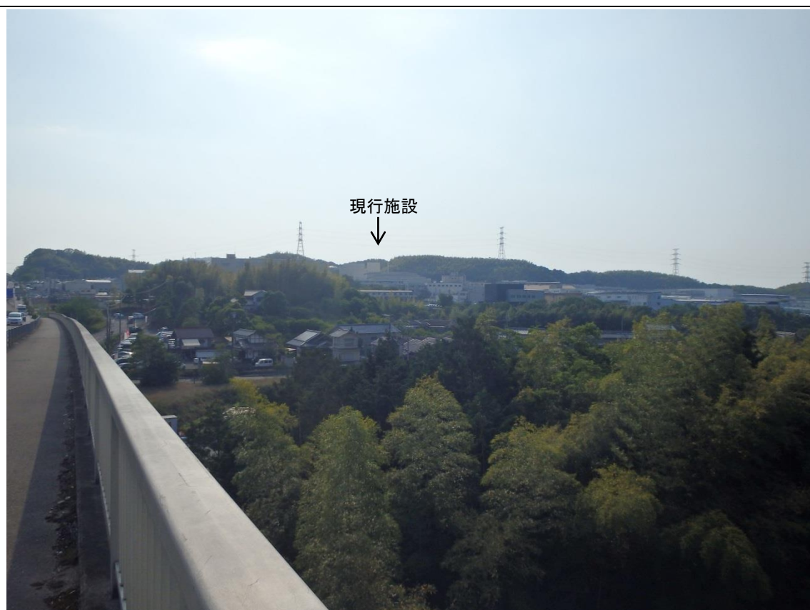
㊸松尾川大橋(国道 170 号)の現況(春季)
