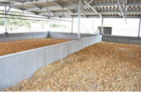
伊賀リサイクルセンター堆肥化施設脱臭装置
