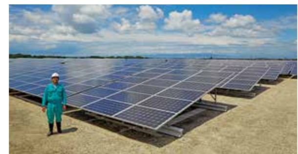
万一の災害時には、非常用電源として地域の電力インフラを支える。
