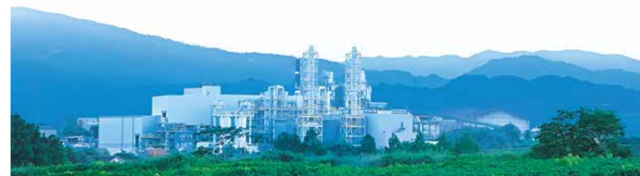
さくらRCからエネルギープラザに運ばれた可燃ごみは、発電やトランスヒートコンテナシステムによる熱供給などエネルギーとしてリサイクルされる。
