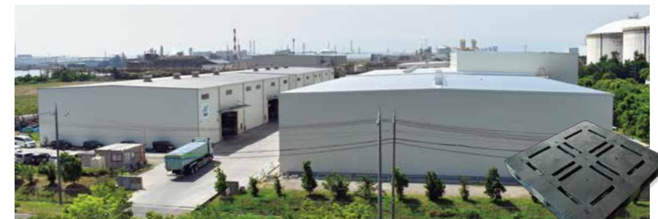
大阪府堺市に建設中のパレット製造設備。
