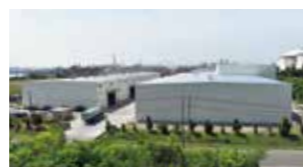
新設パレット工場 大阪府堺市に現在建設中。2021年度から稼働予定です。
