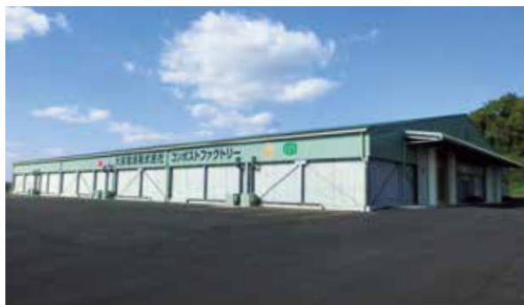
三木RCの堆肥化施設「コンポストファクトリー」。
